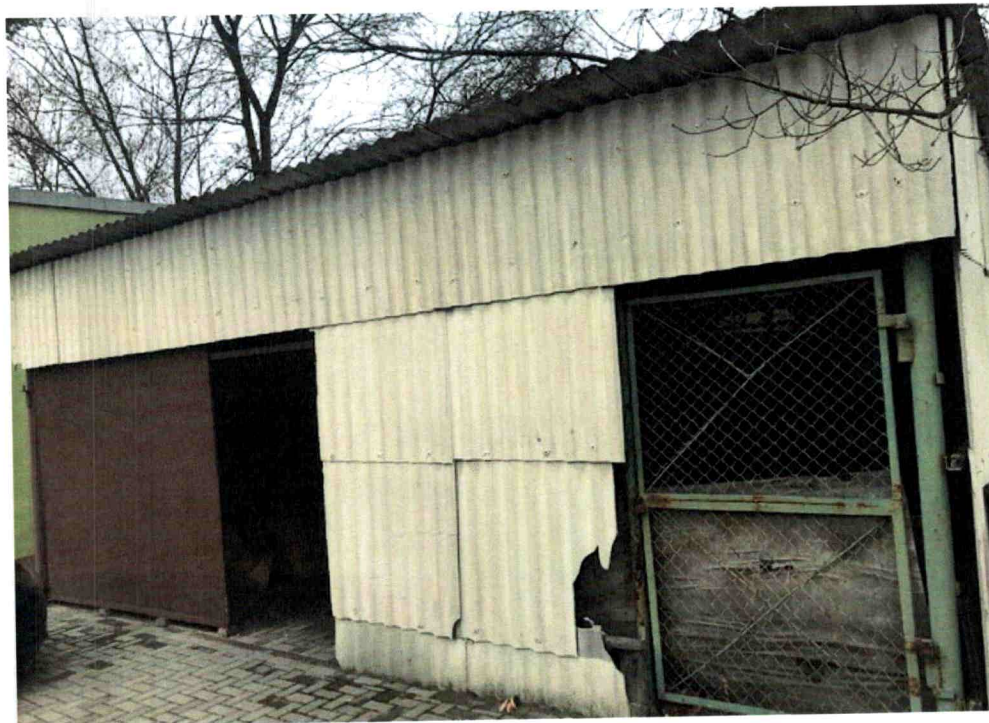
Widok ogólny obiektu
