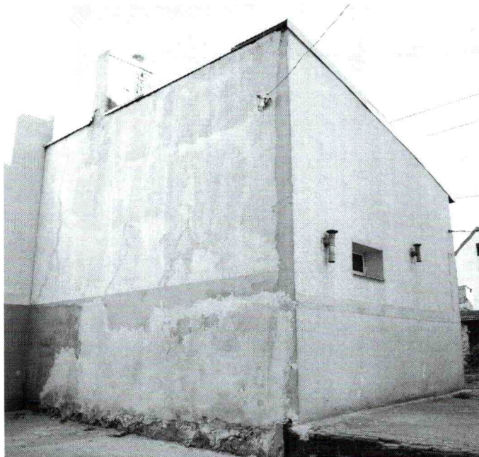
Fot. 4. Widok tylnej i bocznej ściany obserwowanego budynku.
