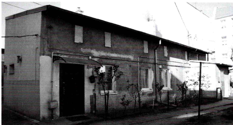
Fot. 3. Widok frontowej i bocznej ściany obserwowanego budynku.
