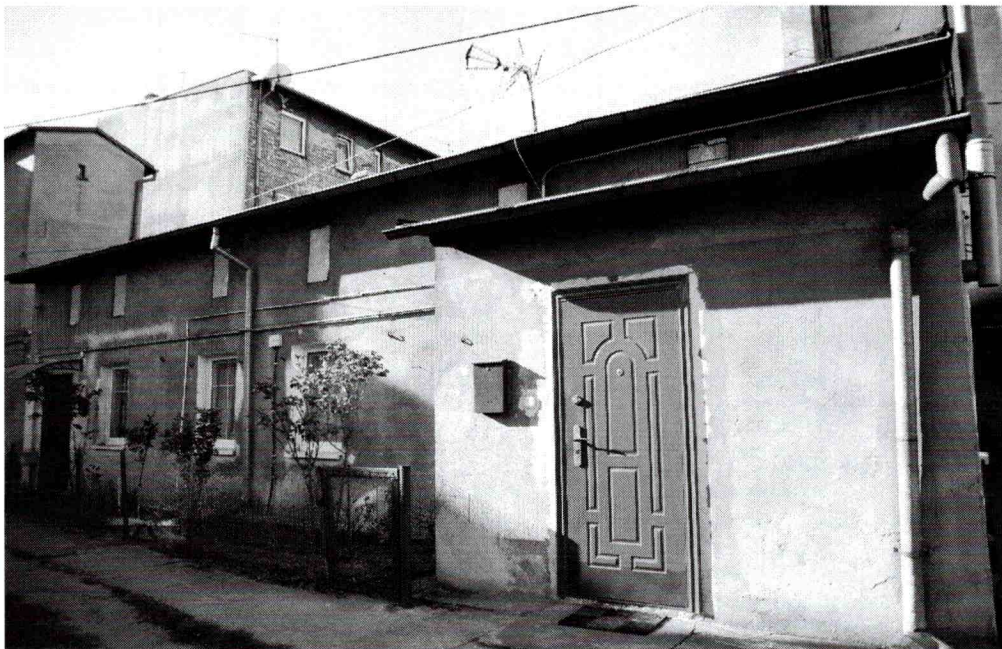
Fot. 2. Widok frontowej ściany obserwowanego budynku.
