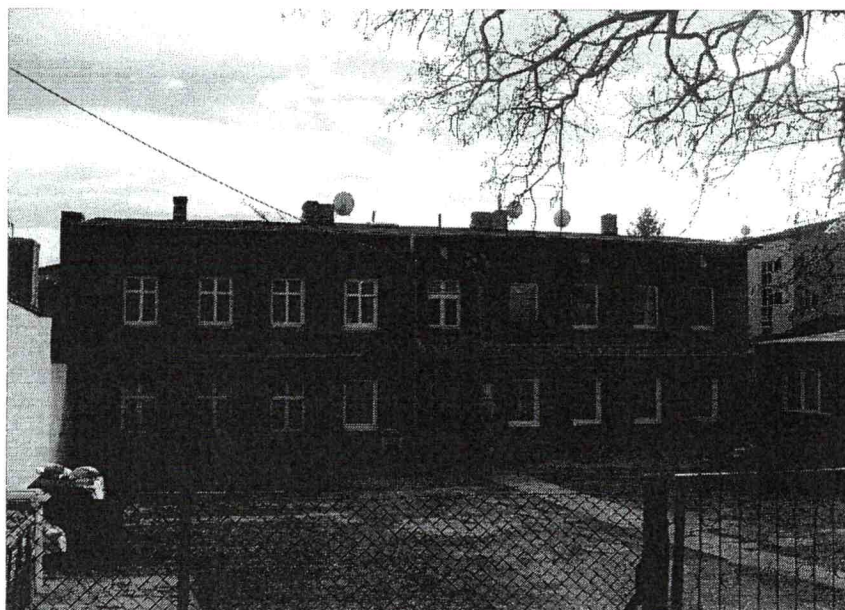
Budynek główny – elewacja północna.
