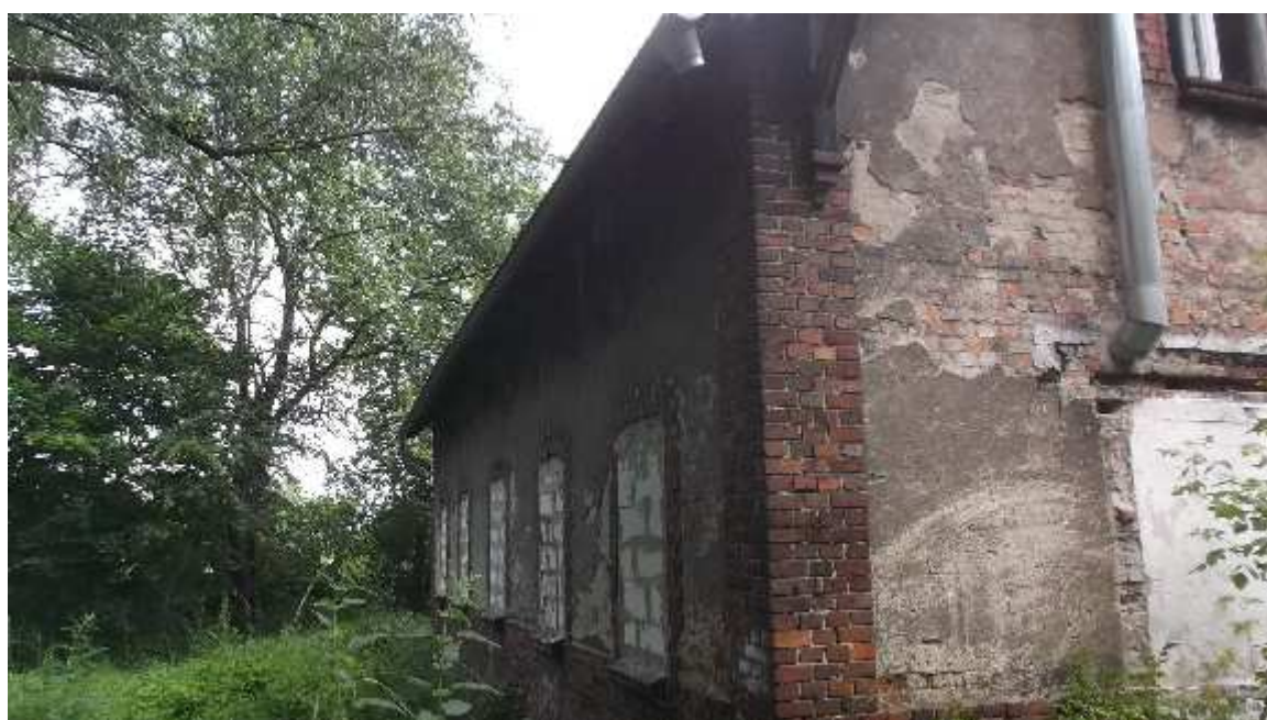
fot. nr 2 Budynek mieszkalny – elewacja tylna. Widoczne ubytki tynku, lokalne ubytki muru.
