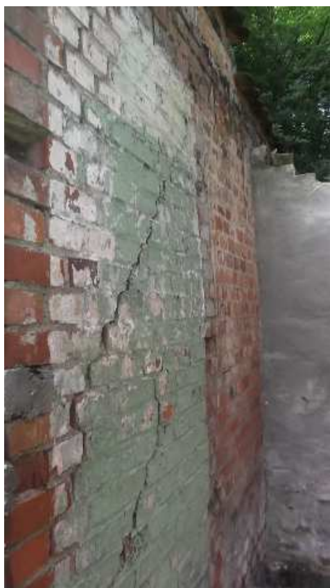
fot. nr 16 Budynek gospodarczy – występujące liczne głębokie spękania muru zagrażające awarią ścian – w trakcie rozbiórki zachować szczególną ostrożność.
