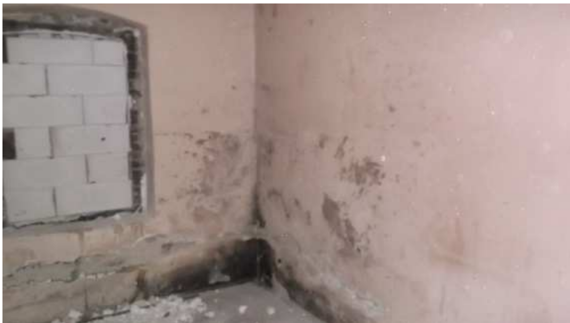
fot. nr 5 Budynek mieszkalny – parter. Zdegradowane wnętrze budynku – rozległe zawilgocenia oraz ubytki muru.
