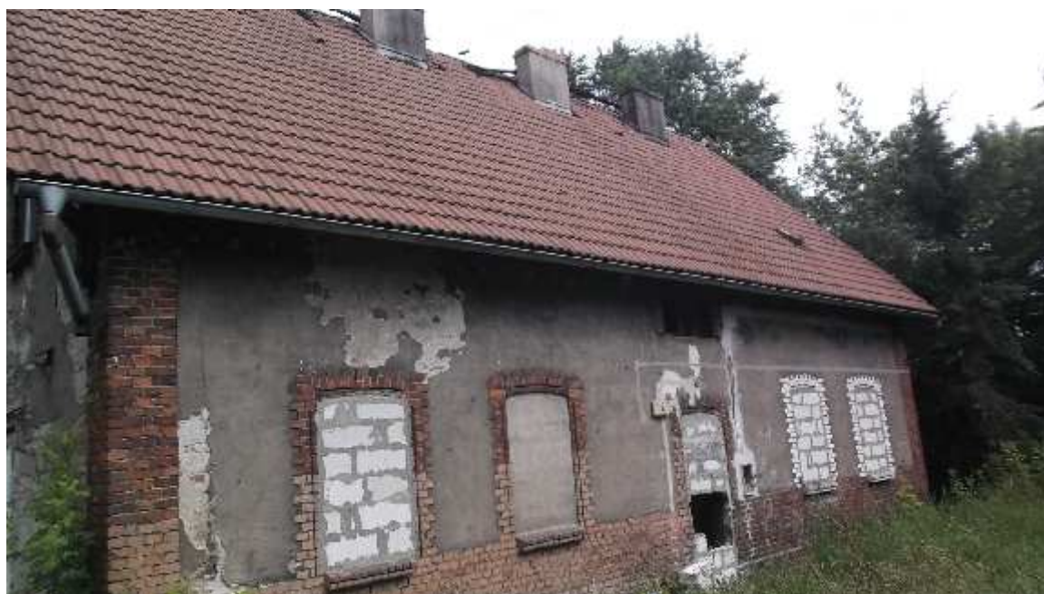
fot. nr 1 Budynek mieszkalny – elewacja frontowa. Widoczne ubytki tynku, zamurowana stolarka okienna oraz spękanie muru przy narożniku na lewo od wejścia głównego.
