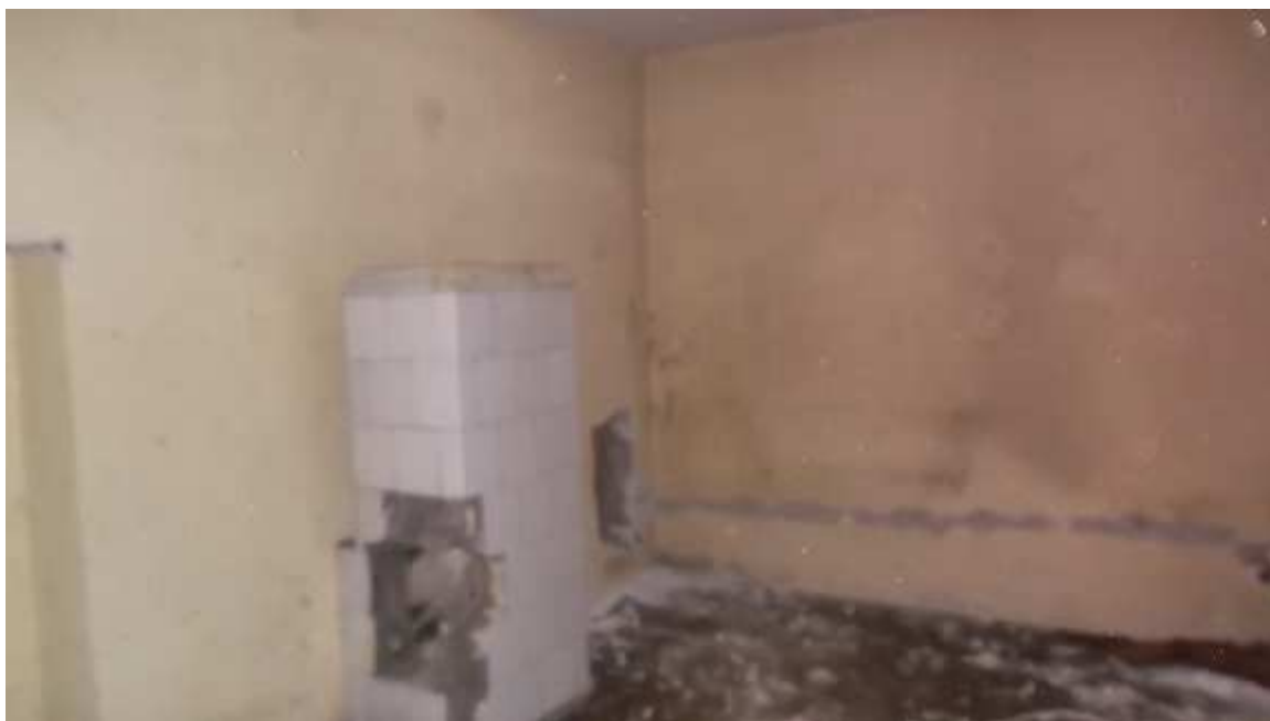
fot. nr 5 Budynek mieszkalny – parter. Zdegradowane wnętrze budynku – rozległe zawilgocenia oraz ubytki muru.
