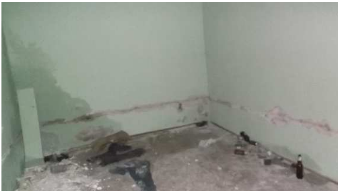
fot. nr 4 Budynek mieszkalny – parter. Widoczne rozległe zawilgocenia ścian zewnętrznych , ubytki muru po brzdowaniu instalacji oraz degradacja warstw wykończeniowych.
