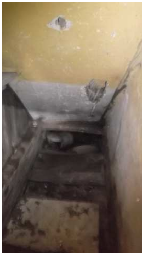
fot. nr 12 Budynek mieszkalny – zejście do piwnicy – zagruzowane/zaśmiecone. Brak dostępu do piwnicy w trakcie inwentaryzacji. W trakcie rozbiórki należy przyjmować założenie podpiwniczenia całości budynku
