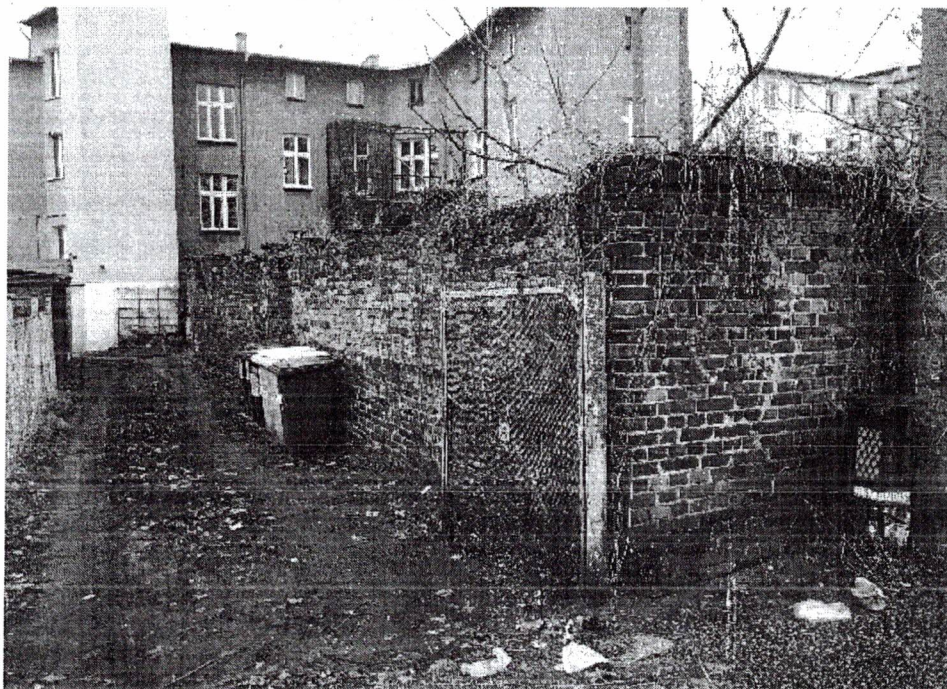
fot. nr 1 Widok ogólny ogrodzenia i drogi dojazdowej do posesji Zduny 21 – słupek bramy wjazdowej oraz bramę na teren ww. posesji zabezpieczyć przez zniszczeniem przez rozpoczęciem robót.
