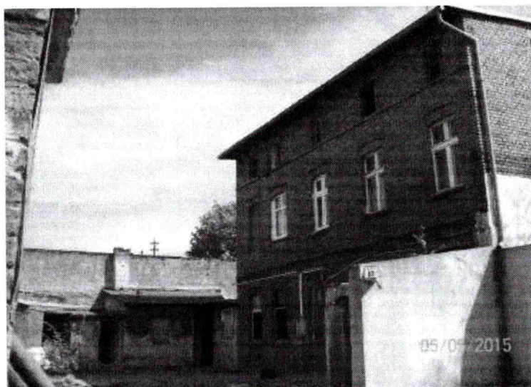
Fot. 1. Elewacja frontowa budynku.
