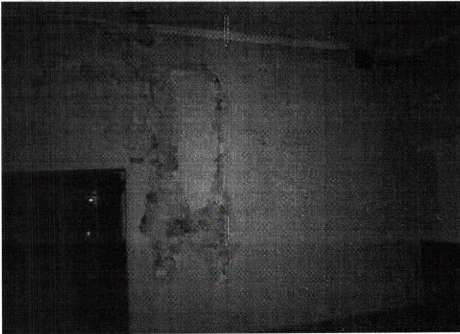
fot. nr 7 Wnętrze budynku nr 32/6:1 – widoczne głębokie bruzdowania ścian wskutek usunięcia instalacji.
