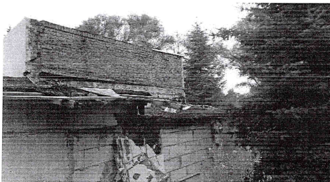
fot. nr 1 Widok ogólny budynku przewidzianego do rozbiórki – część wysoka. Widoczne ugięcia więźby dachowej oraz zamurowane otwory okienne.
