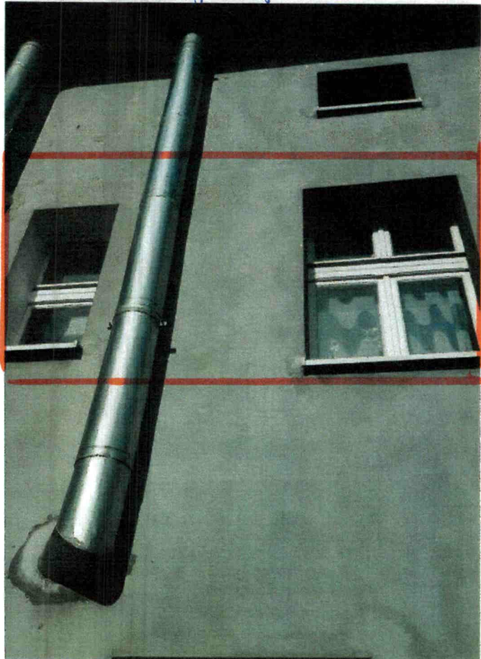
Widok od strony podwórza
