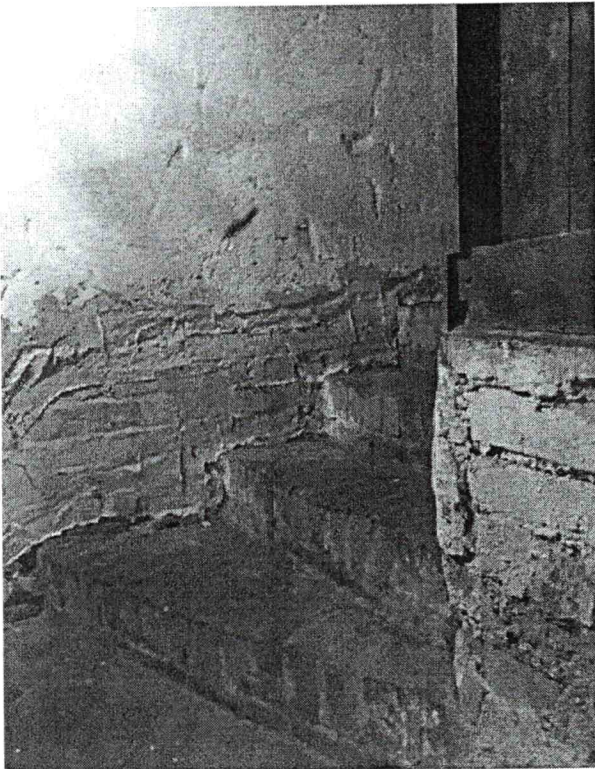
fot. nr 7 Piwnica budynku mieszkalnego – widoczne zagrzybienia oraz ubytki muru.
