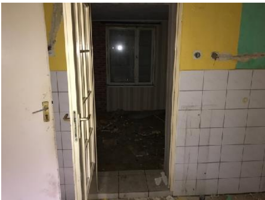
fot. nr 8 Parter budynku – widoczne głębokie bruzdowania ścian.
