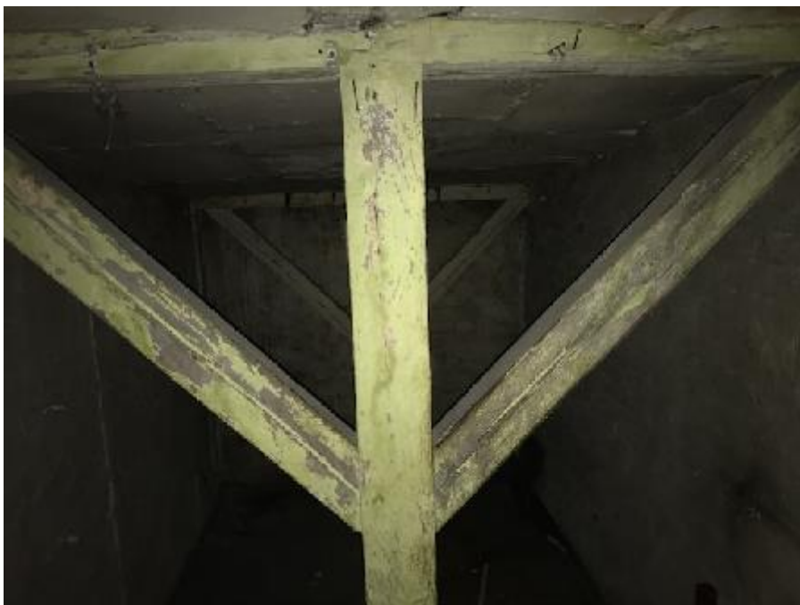
fot. nr 5 Elementy więźby dachowej – widoczna degradacja elementów.
