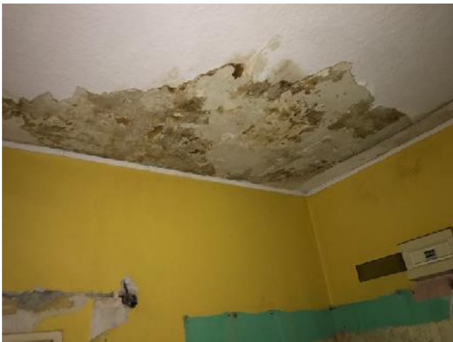
fot. nr 7 Rozległe zawilgocenie stropu parteru.
