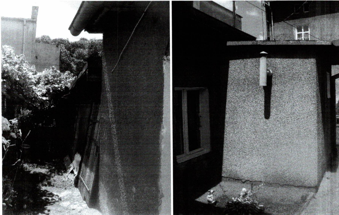
Część gospodarcza (południowa) i wejście do części mieszkalnej.
