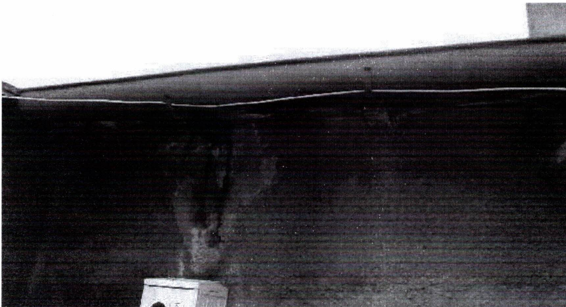
fot. nr 5 Ściany części mieszkalnej – widoczne zawilgocenia oraz ubytek konstrukcji murowej.
