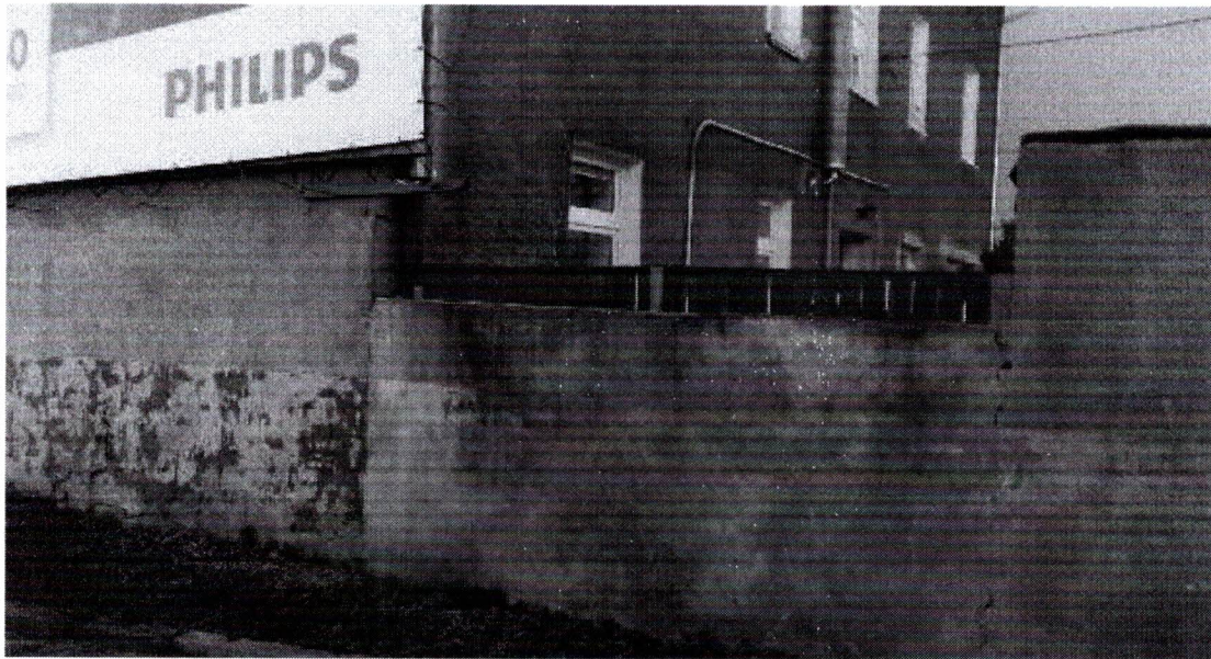
fot. nr 10 Fragment ogrodzenia przy budynku głównym – do pozostawienia bez rozbiórki, obiekt zabezpieczyć przed uszkodzeniem w trakcie prowadzenia robót rozbiórkowych oraz dokonać niezbędnych napraw po zakończeniu robót rozbiórkowych celem zapewnienia stateczności elementu.
