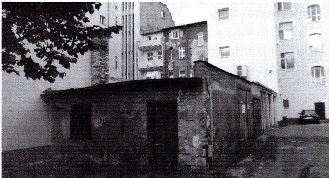
fot. nr 1 Widok ogólny budynku przewidzianego do rozbiórki – widoczny brak liniowości krawędzi dachu, ubytki ścian murowanych obiektu. Widoczne obiekty sąsiadujące – budynek na działce nr 63/6 oraz ciąg garaży na działce nr 65/10.
