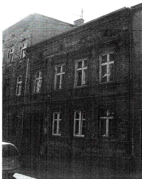
Elewacja frontowa – północna.
