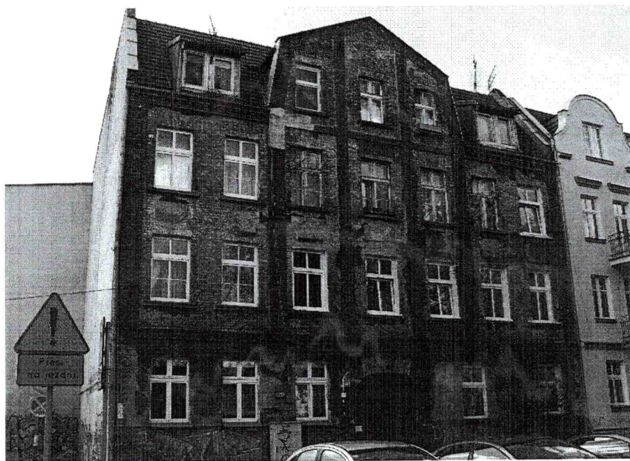
Elewacja frontowa – północna
