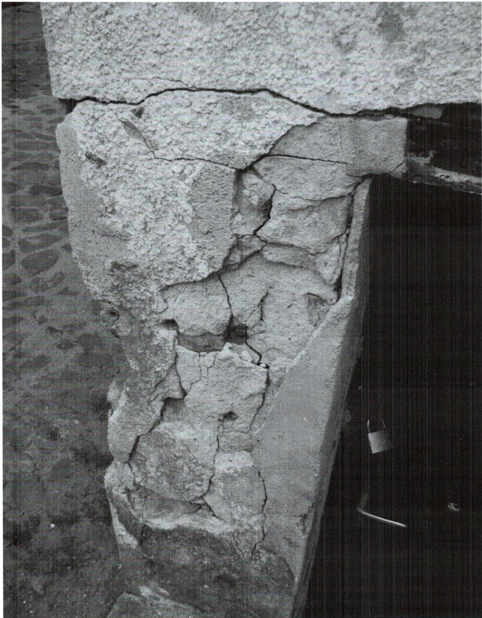
Foto.4 Korozja ściany
