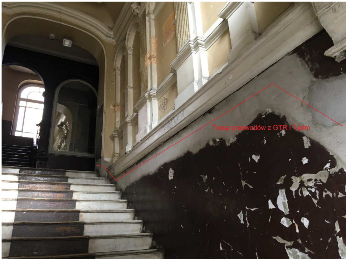
Rys. 1. – Przebieg przewodów na parterze – wejście główne
