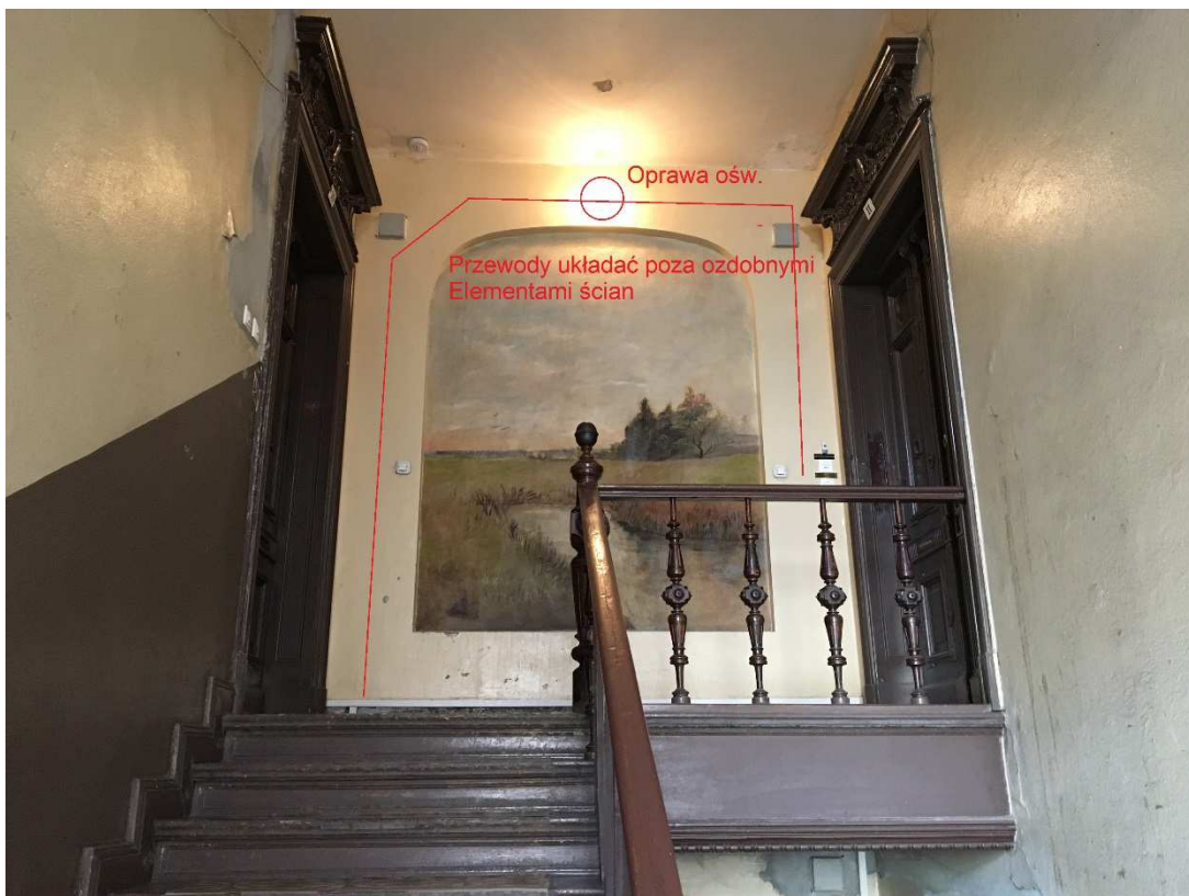
Rys. 6. – Trasa przewodów i montaż oprawy - II piętro
