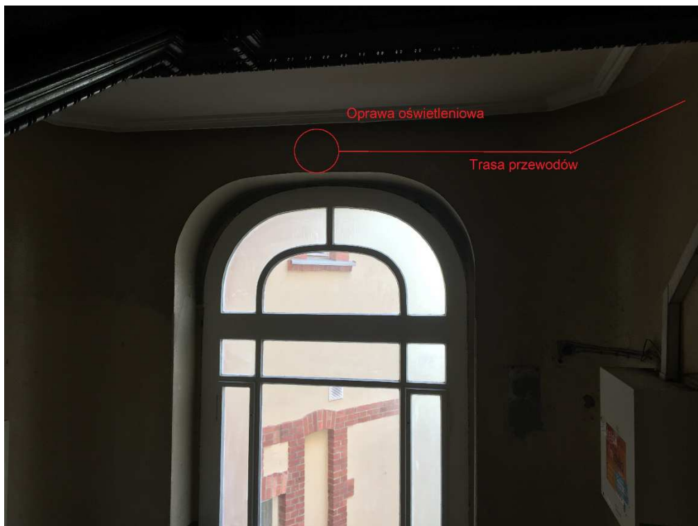
Rys. 4. – Miejsce montażu oprawy + trasa przewodów – półpiętro
