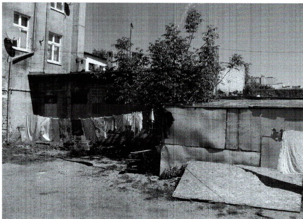
Pomieszczenia przynależne do lokalu użytkowego. Widok od zachodu.
