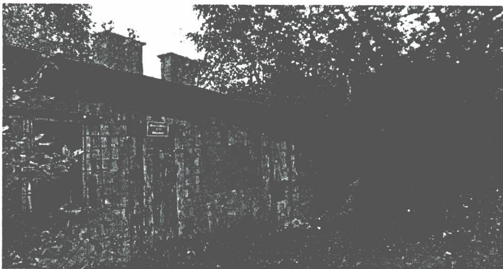
Fot. nr 15 – budynek gospodarczy „A” – inwentarski – elewacja frontowa
