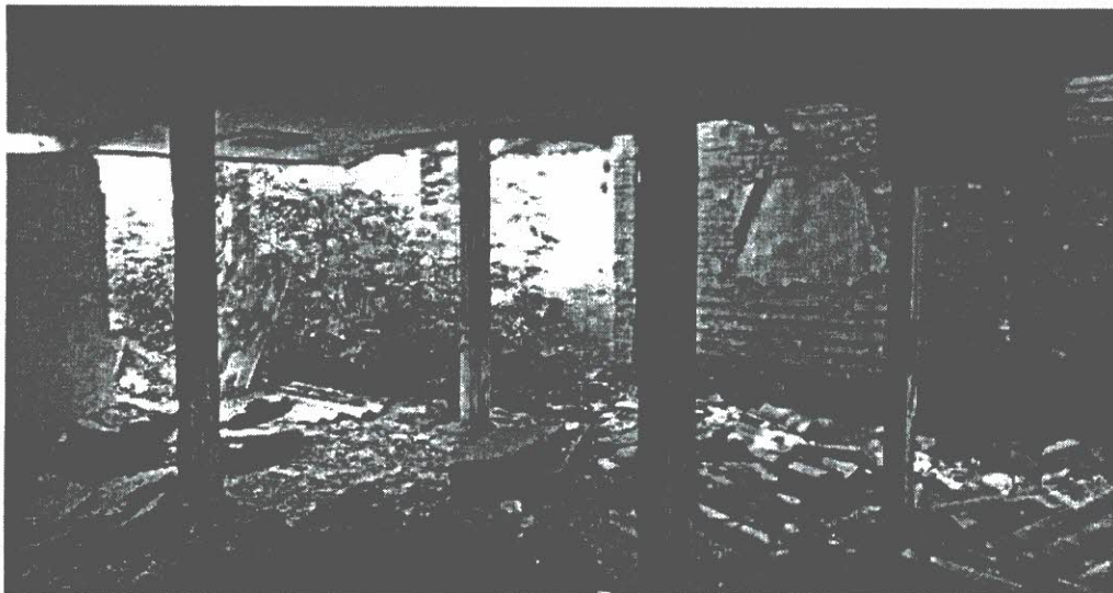
Fot. nr 19 – budynek gospodarczy „B” – widoczne zaśmiecenie wnętrza obiektu zerwanymi elementami stropu parteru, uszkodzenia konstrukcji muru oraz awaryjny stan techniczny stropu parteru.
