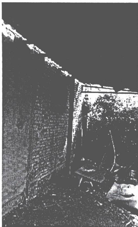
Fot. nr 21 – budynek gospodarczy „C” – szopa – ściany budynku w znacznym stopniu zdegradowane, pokrycie dachu uszkodzone, widocznie ugięte.
