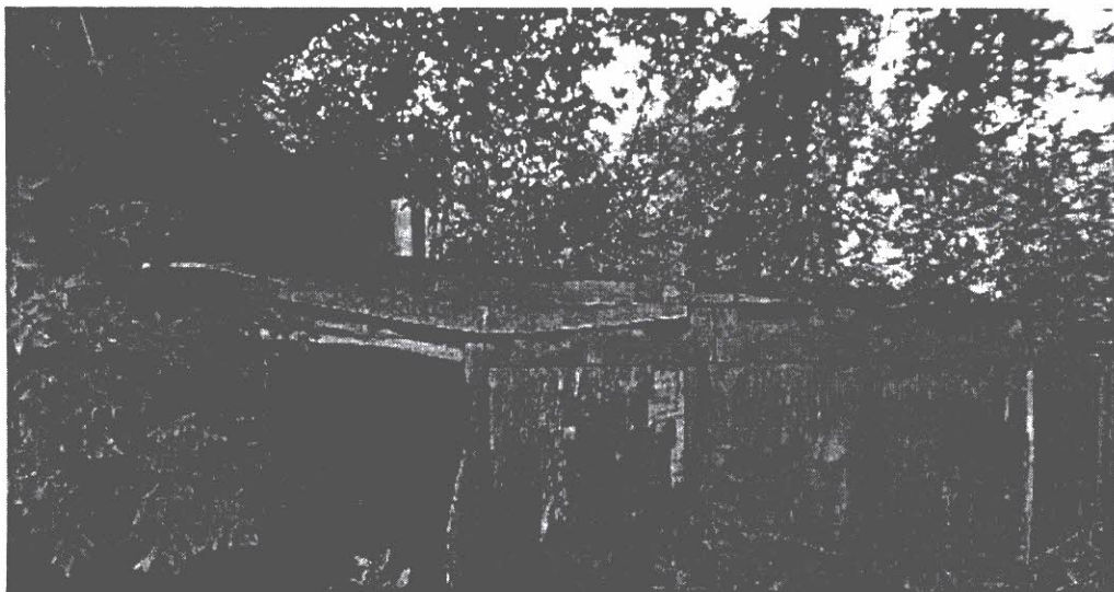
Fot. nr 21 – budynek gospodarczy „C” – szopa – ściany budynku w znacznym stopniu zdegradowane, pokrycie dachu uszkodzone, widocznie ugięte.
