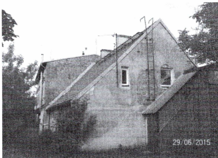
Fot.2. Elewacja zachodnia
