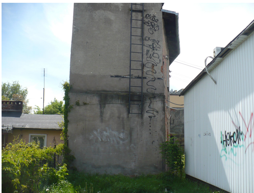
zdj. 3. elewacja szczytowa
