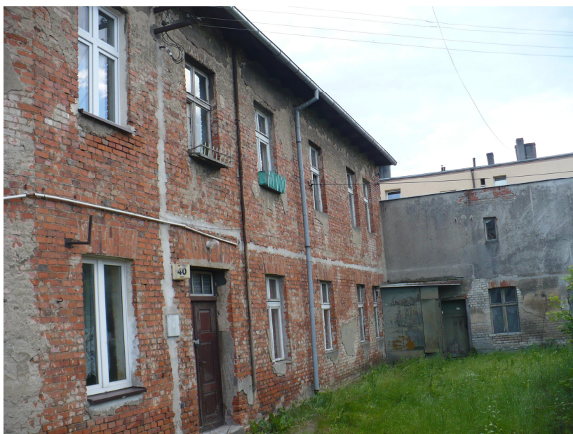
zdj. 1. elewacja frontowa
