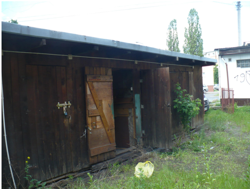
zdj. 6. elewacja frontowa
