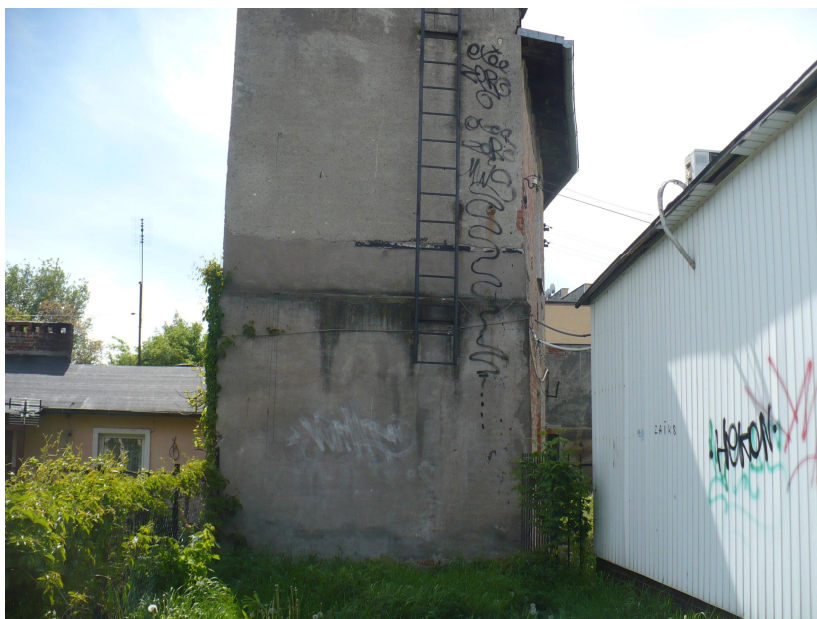
zdj. 5. elewacja szczytowa
