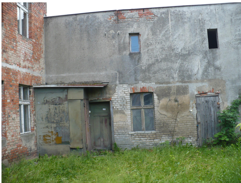
zdj. 4. elewacja frontowa
