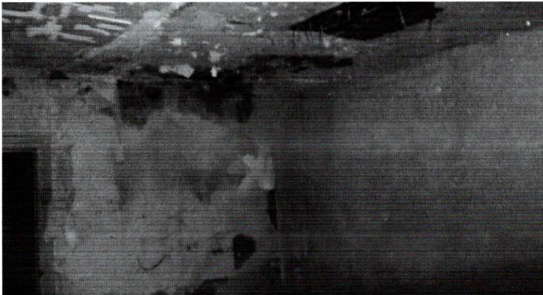
fot. nr 7 Wnętrze obiektu – naruszony strop parteru – lokalnie zarwany, z licznymi ubytkami. Ściany obiektu w znacznym stopniu zdegradowane.
