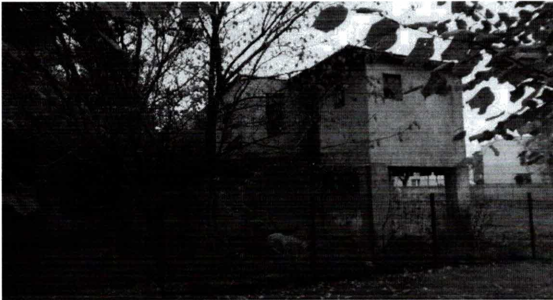
fot. nr 3 Widok obiektu od strony budynku pod adresem Jaskółcza 48. Część dobudowana oparta na 4 filarach – element podstemplować przed rozbiórką części nadziemnej, zabrania się wykonywania rozbiórki poprzez podcinanie lub przewracanie filarów.
