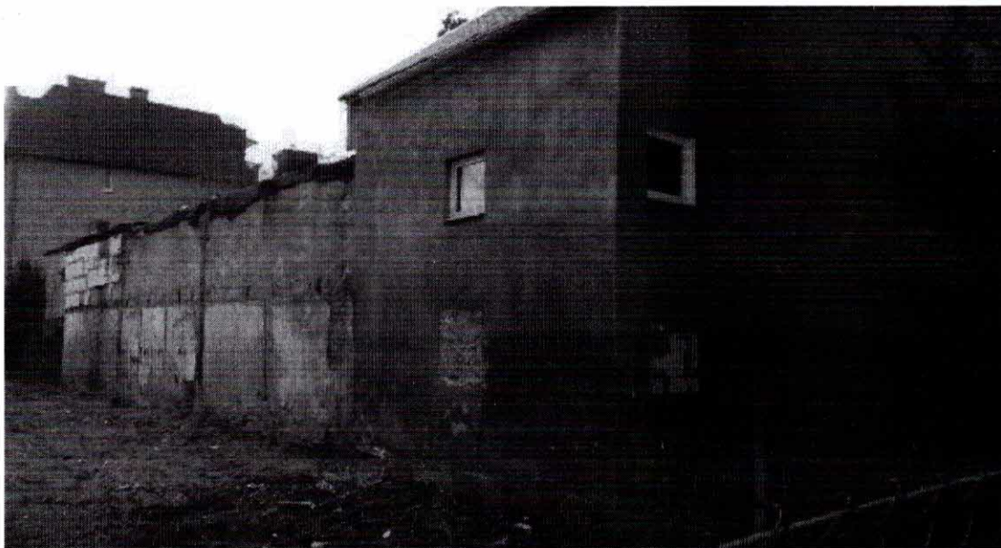
fot. nr 1 Widok ogólny budynku przewidzianego do rozbiórki od strony ul. Gołębiej– część frontowa z dachem dwuspadowym kryta dachówką, w tle widoczna część niższa z dachem jednospadowym krytym papą.
