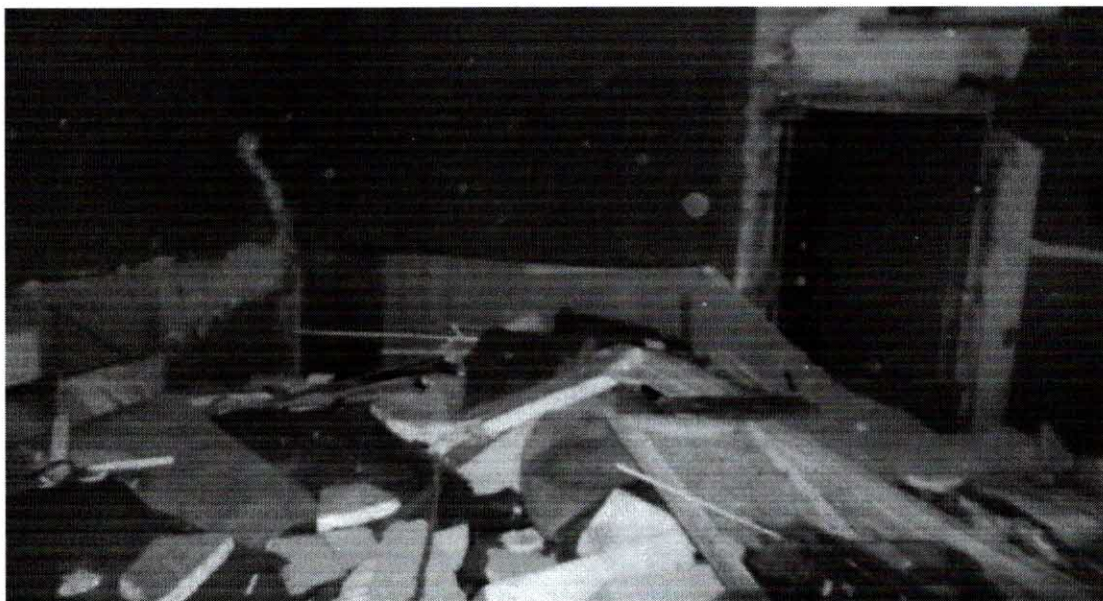
fot. nr 7 Wnętrze obiektu – naruszony strop parteru – lokalnie zarwany, z licznymi ubytkami. Ściany obiektu w znacznym stopniu zdegradowane.
