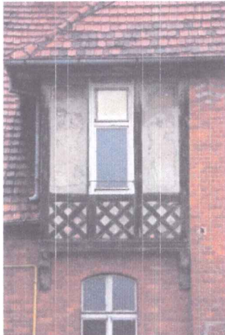
Zdjęcie 4: Fragment elewacji AB z widocznym murem pruskim
