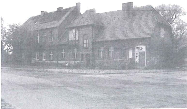
Elewacja północna (frontowa) i zachodnia.
