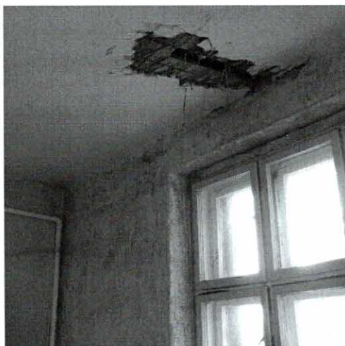
Uszkodzenie deskowania
