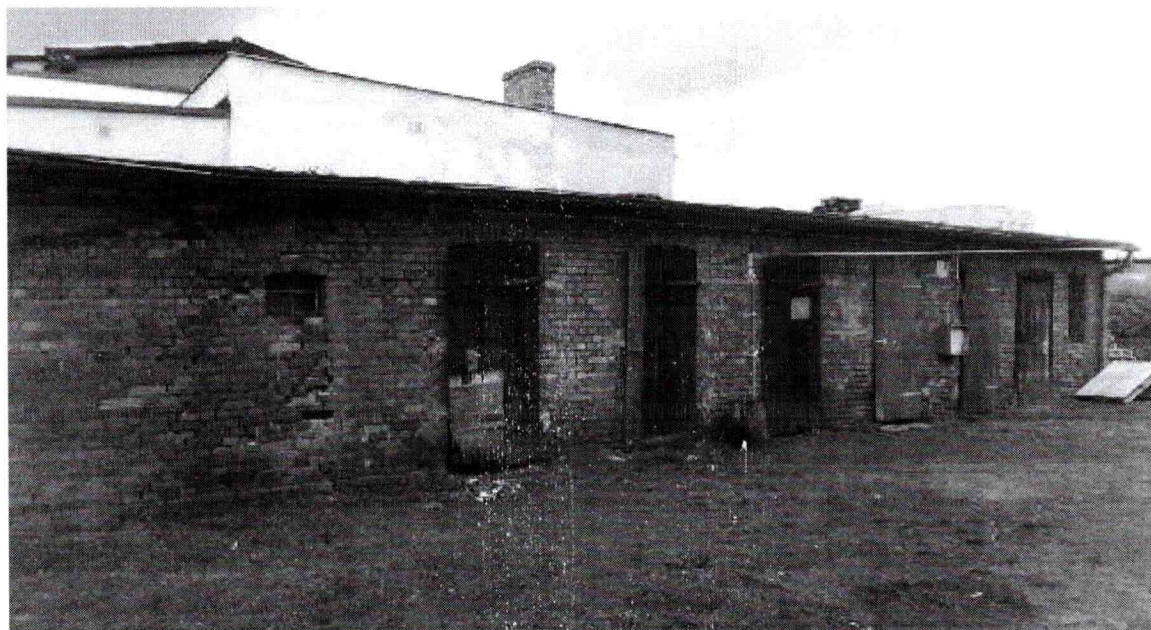
fot. nr 1 Widok ogólny obiektu, ściana w osi 2.
