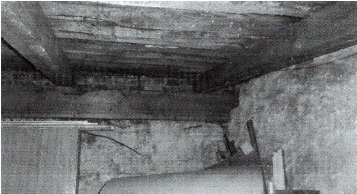
fot. nr 13 Wnętrze budynku gospodarczego w miejscu połączenia z ścianą budynku frontowego w osi 1 – widoczne oparcie konstrukcji dachu komórek gospodarczych na pogrubionych ścianach w miejscu styku z budynkiem frontowym.
