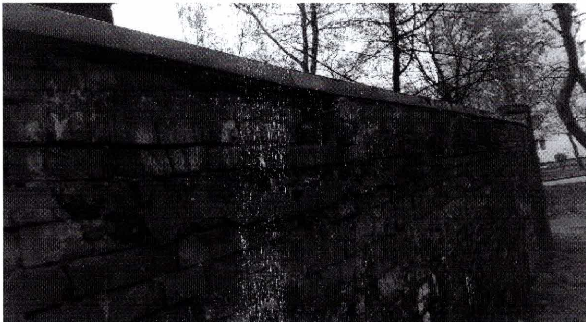
fot. nr 7 ściana w osi 1 budynku – ubytki muru.
