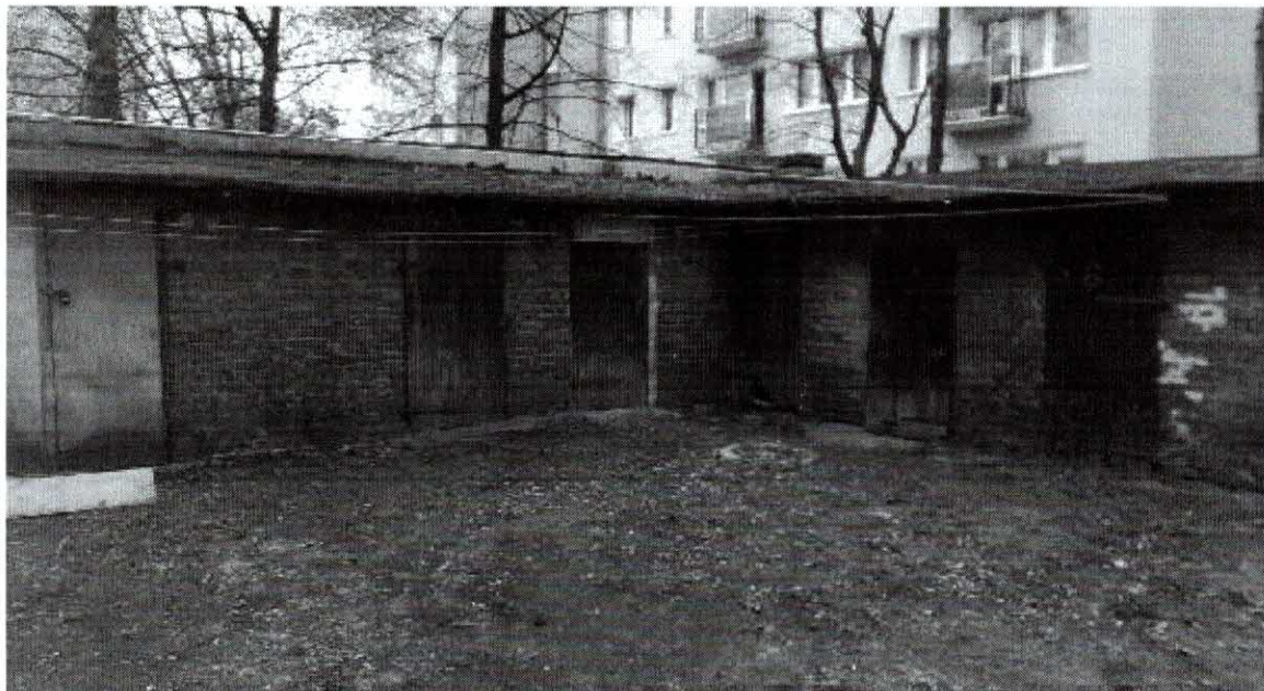
fot. nr 1 Widok ogólny budynku cz. 1 – widoczne ugięcia płaszczyzny zadaszania obiektu.
