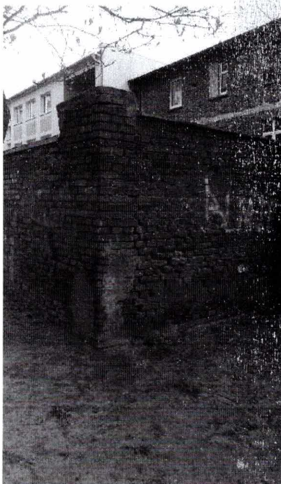
fot. nr 7 ściana w osi 1 budynku – ubytki muru.
