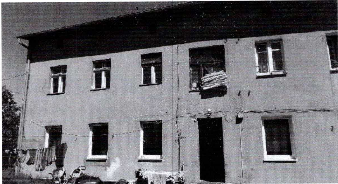
Fot. nr 7 – elewacja budynku od strony podwórza.
