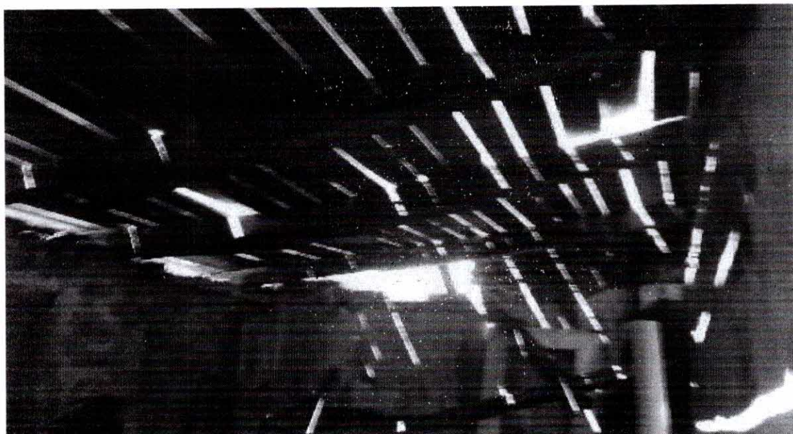
Fot. nr 11 – dach budynku gospodarczego murowanego – w stanie technicznym awaryjnym, liczne ubytki poszycia oraz ugięcie belek nośnych konstrukcji więźby.
