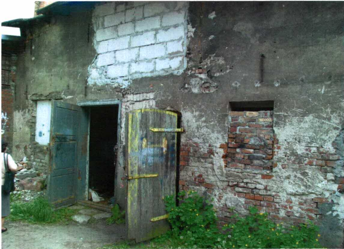
Foto.3 Widok budynku od frontu
