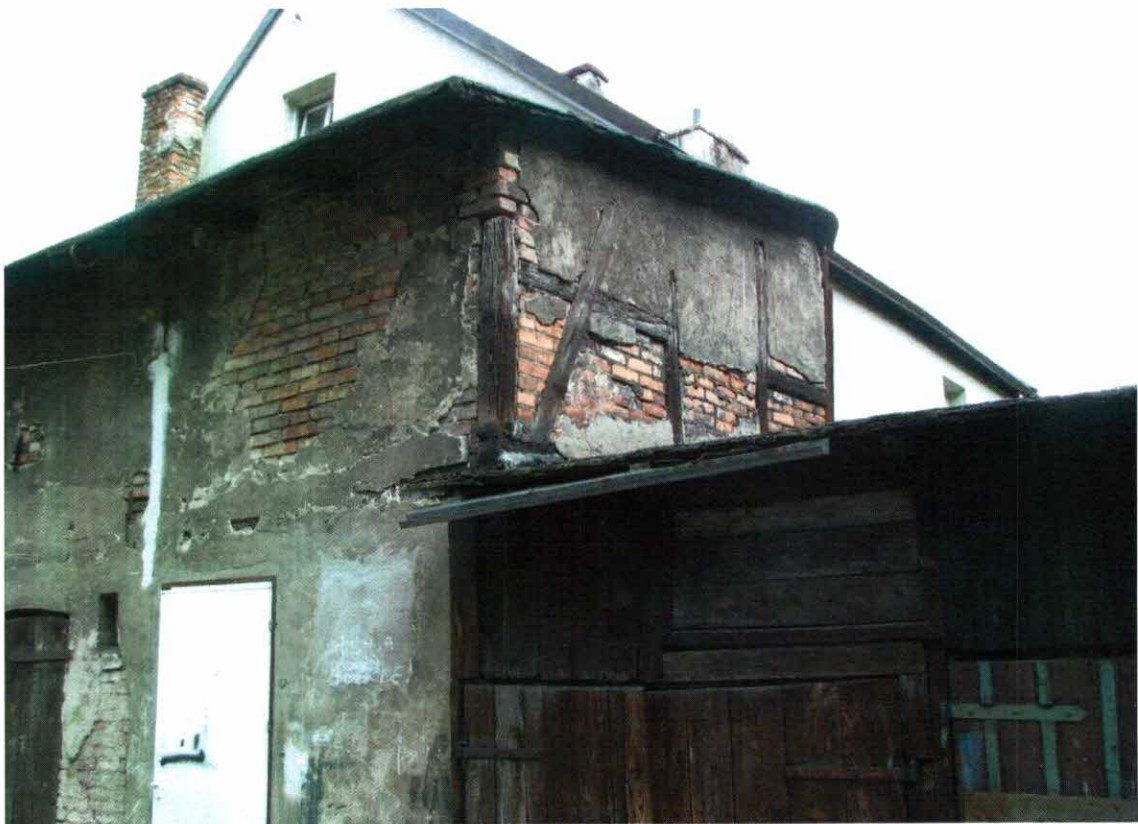
Foto.4 Widok na ścianę szczytową
