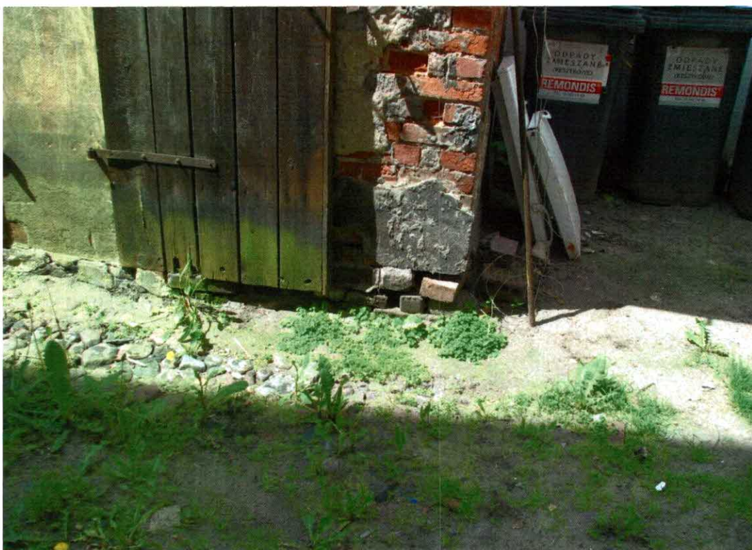
Foto.3 Widok na ścianę nośną
