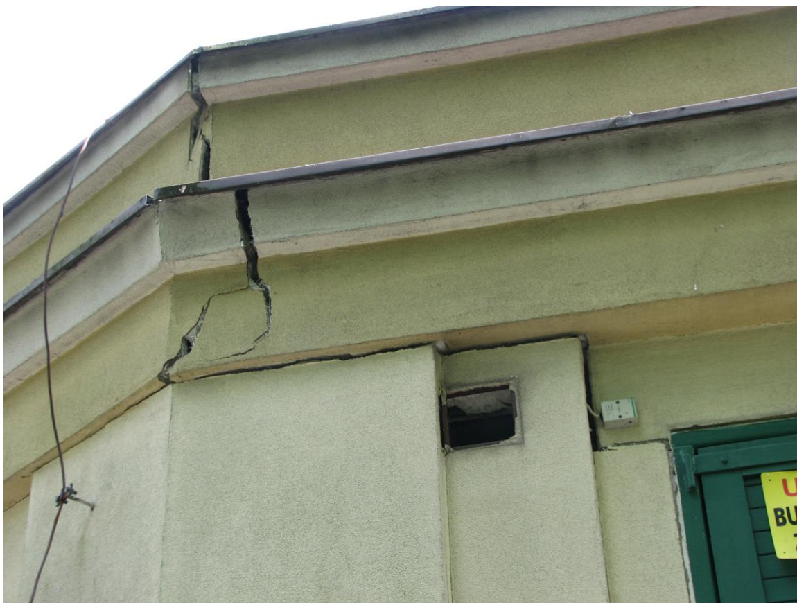
Foto.4 Spękany gzyms
