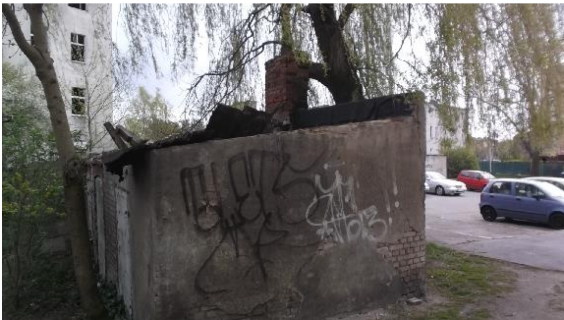
fot. nr 5 Widok budynków od strony ściany w osi A. Widoczne lokalne ubytki oraz spękania muru i tynku oraz konstrukcja dachu po awarii (więźba dachowa zarwana).
