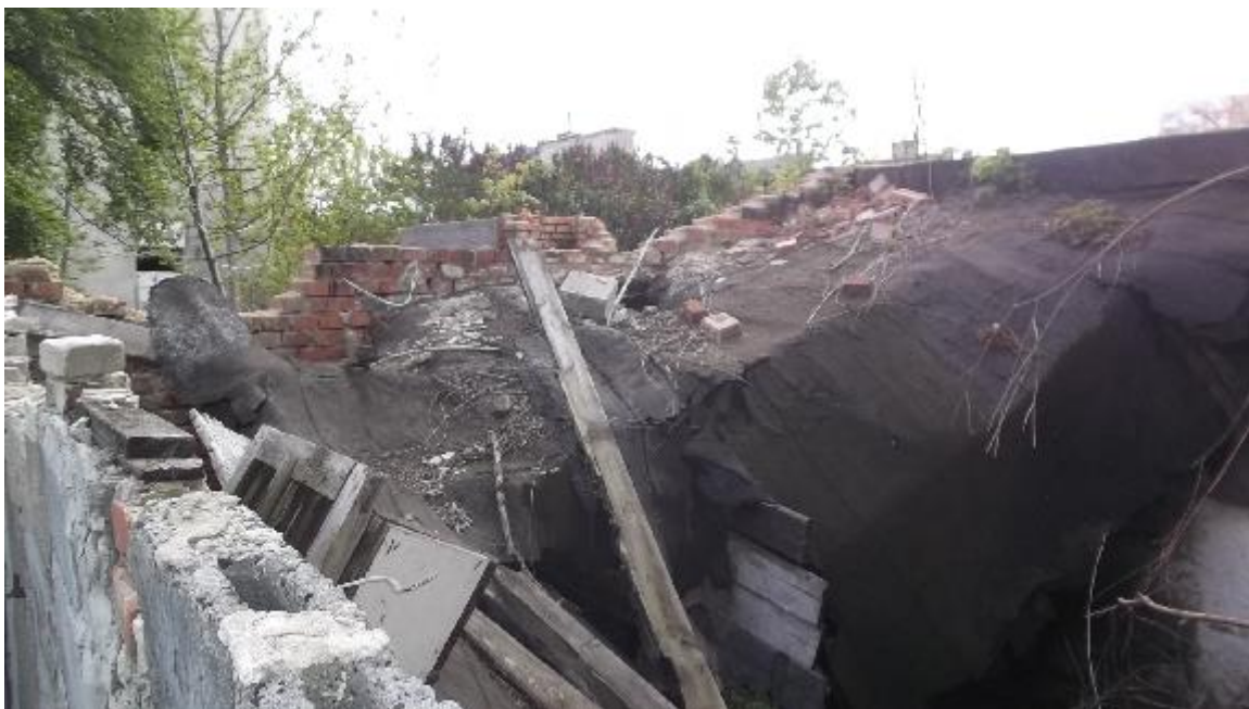
fot. nr 7 Widok wnętrza zabudowań 3 – ubytki muru, zarwana konstrukcja poszycia dachu.
