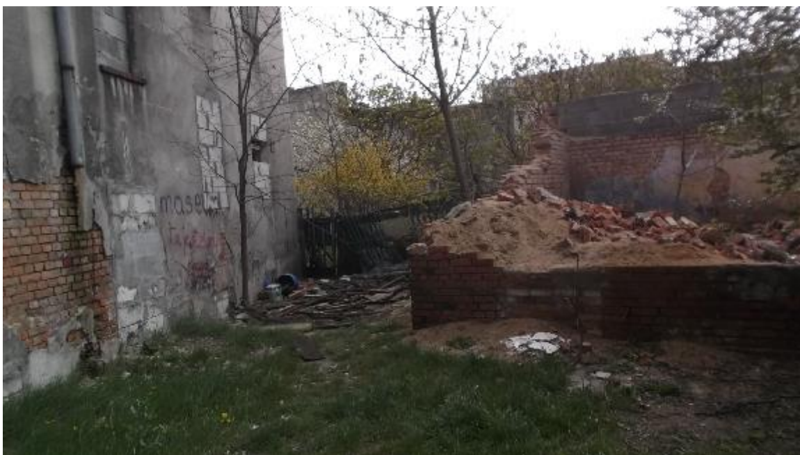
fot. nr 1 Widok budynków, osie C-E. Na zdjęciu widoczne znaczne zagruzowanie wnętrza obiektu – gruz oraz piasek do usunięcia na etapie robót przygotowawczych.
