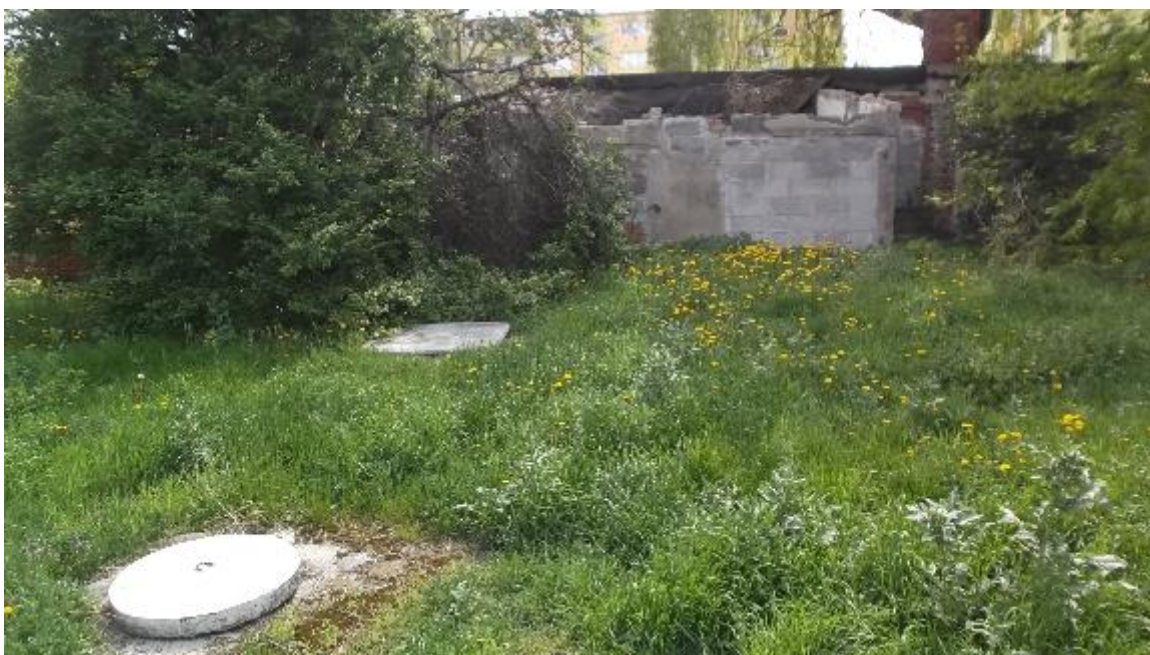
fot. nr 8 Szamba przed budynkiem – do zabezpieczenia w trakcie robót rozbiórkowych, zapewnić odpowiednie wyгородzenie celem uniknięcia zarwania i wypadnięcia pracowników lub sprzętu
