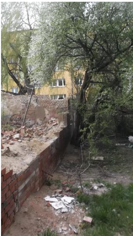
fot. nr 5 Widok budynków od strony ściany w osi A. Widoczne lokalne ubytki oraz spękania muru i tynku oraz konstrukcja dachu po awarii (więźba dachowa zarwana).
