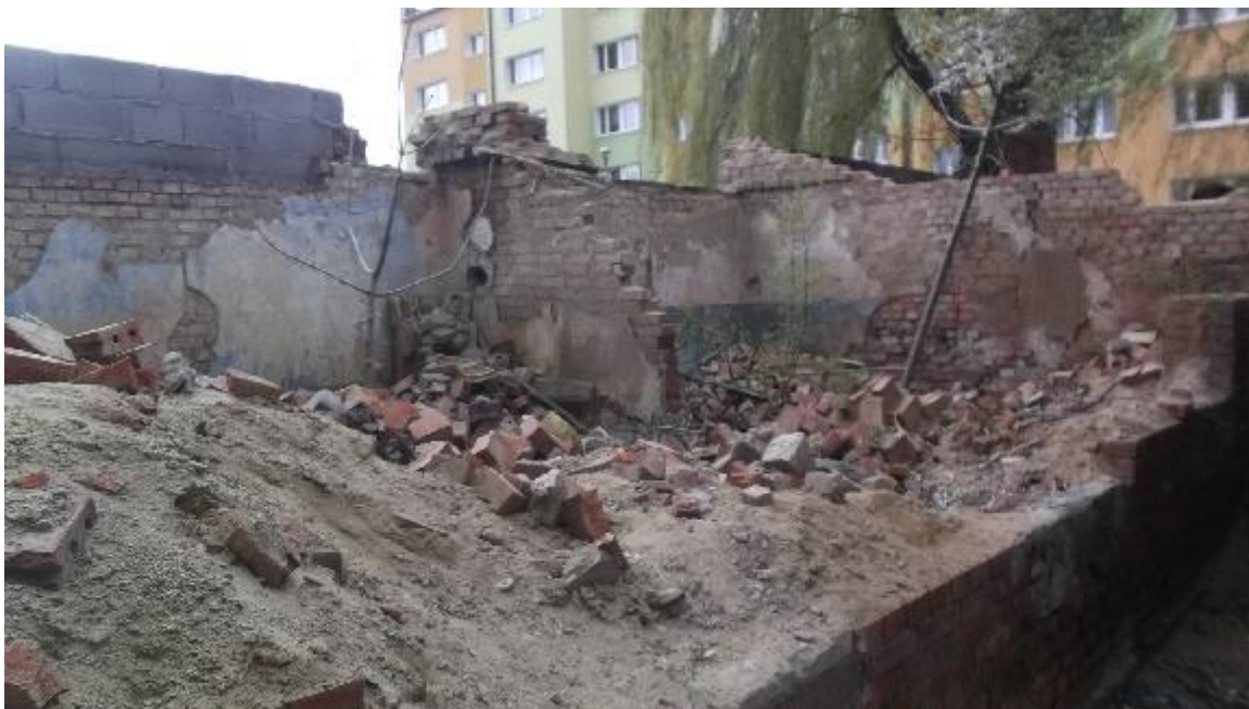
fot. nr 1 Widok budynków, osie C-E. Na zdjęciu widoczne znaczne zagruzowanie wnętrza obiektu – gruz oraz piasek do usunięcia na etapie robót przygotowawczych.
