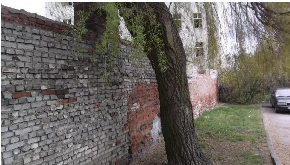
fot. nr 3 Widok ściany w osi 3 budynków – widoczne ubytki muru, spękania, ślady napraw. W bliskim sąsiedztwie ściany zlokalizowane drzewo oraz parking osiedlowy ogólnodostępny.
