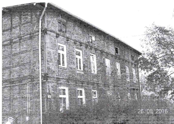
Fot. 1. Elewacja północna budynku.
