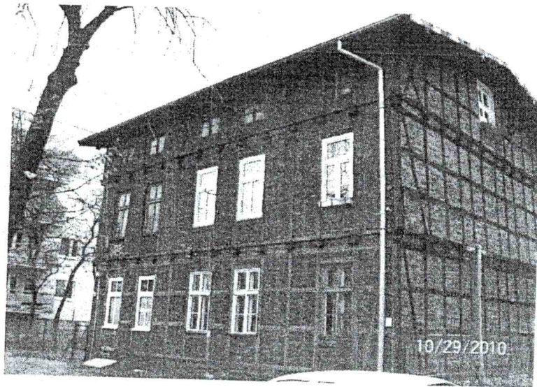
Fot. 1. Elewacja północna budynku.
