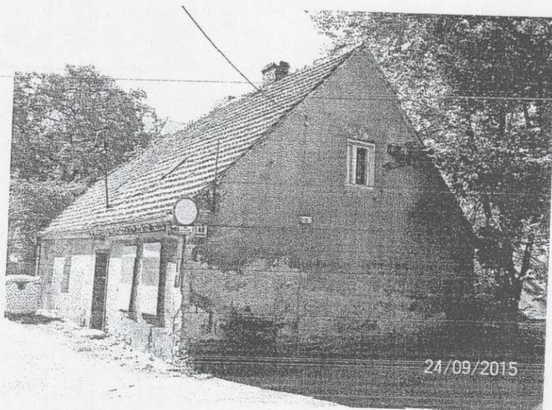
Fot. 1. Elewacja północna budynku.
