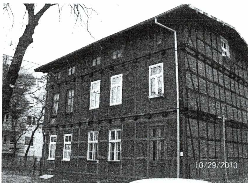
Fot. 1. Elewacja północna budynku.
