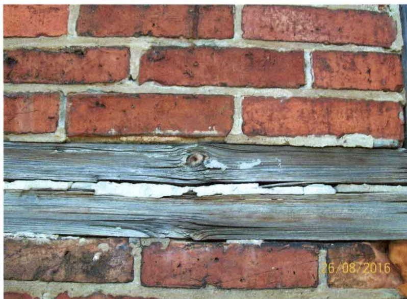
Fot.3. Ubytki drewna uzupełnione zaprawą cementową.
