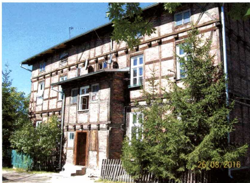
Fot.2. Elewacja południowa (tylna).
