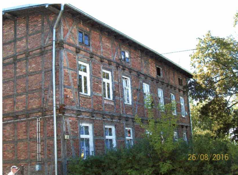
Fot.1. Elewacja północna budynku.
