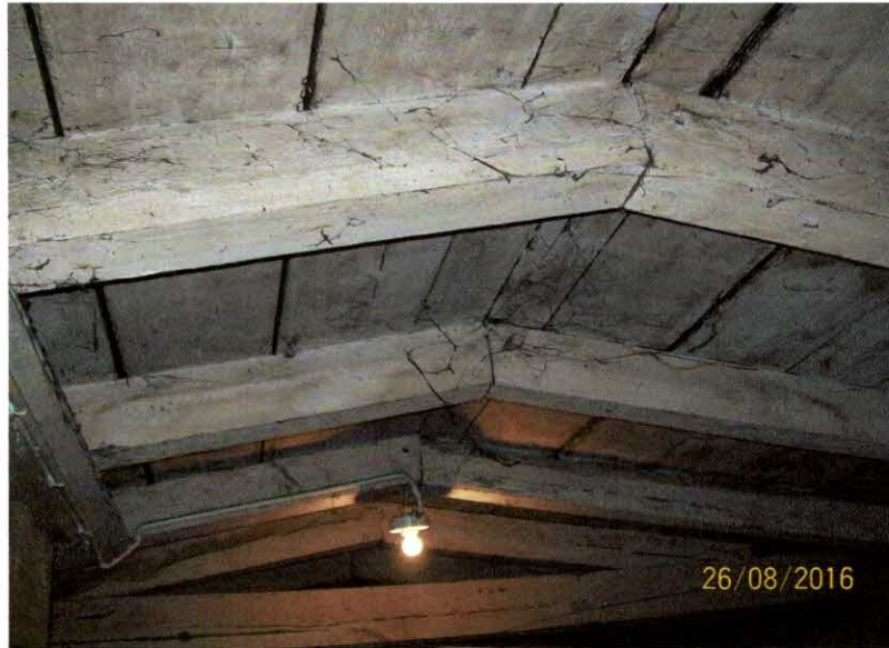
Fot.13. Fragment więźby dachowej w środkowej części budynku.
