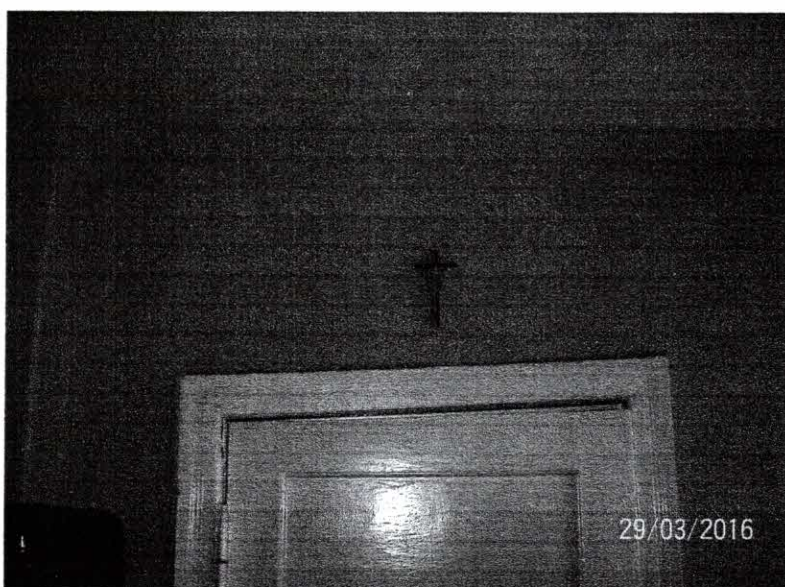
Fot.4. Zdeformowane drzwi i ościeżnica w mieszkaniu nr 15.
