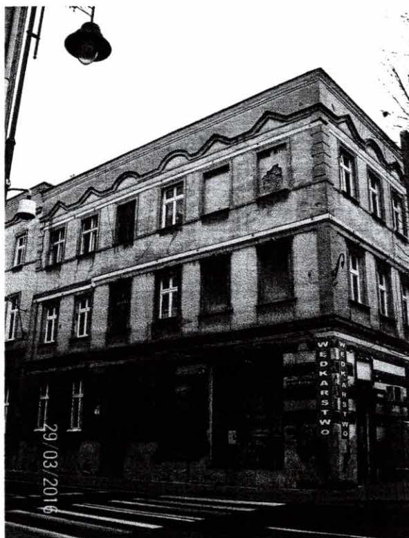
Fot. 1. Elewacje północna i zachodnia.
