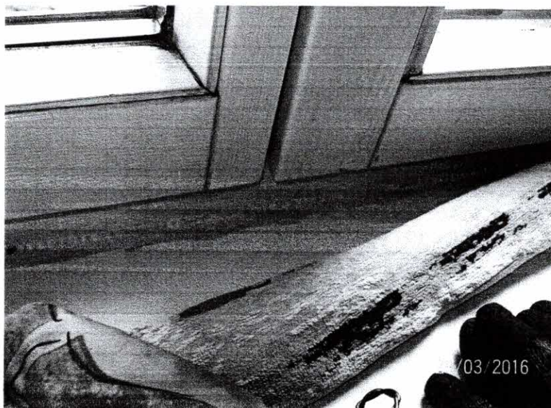
Fot.6. Uszczelnione silikonem połączenie ościeży ze ścianą zewnętrzną.
