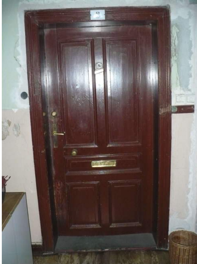
Istniejąca stolarka drzwiowa (stolarka odtworzeniowa Dz1)
