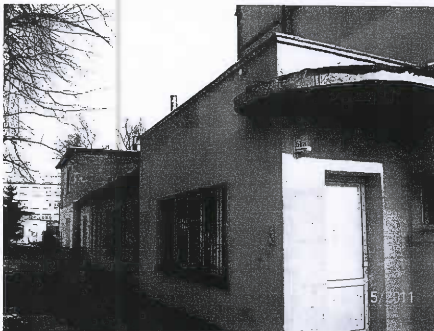
Fot. 1. Widok ogólny budynku użytkowego.
