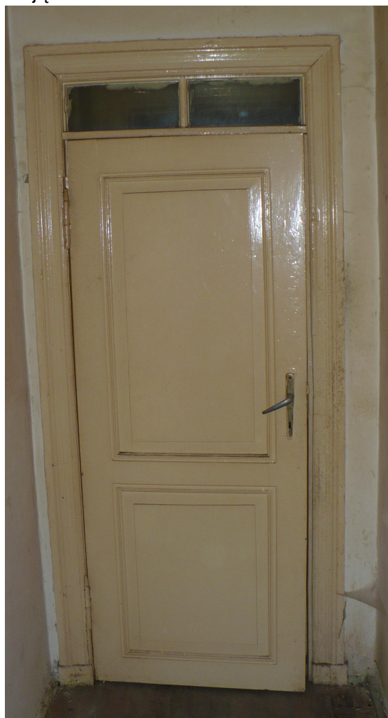
Istniejąca stolarka drzwiowa D2
