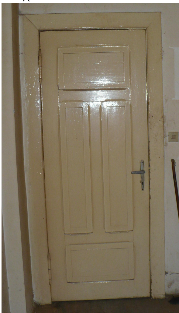
Istniejąca stolarka drzwiowa D3
